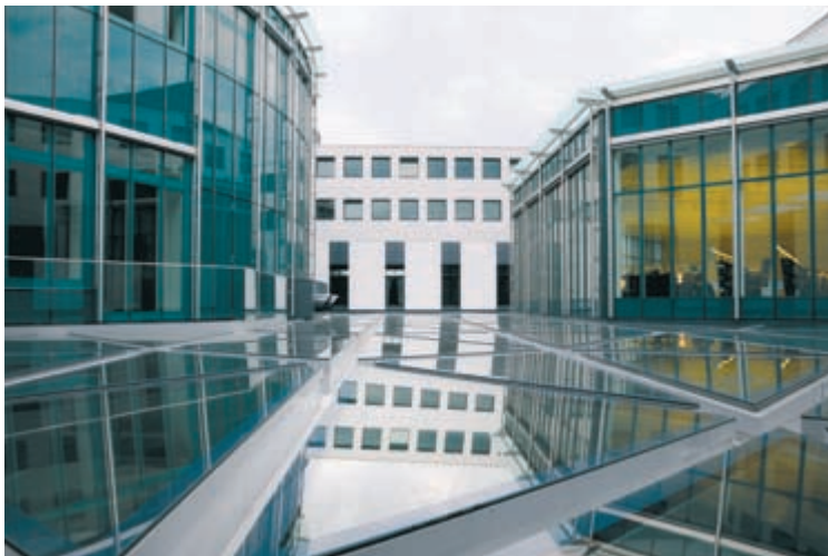
Im Rahmen des Risikomanagements beurteilt der Infrastrukturbereich Immobilien die maximale Tragkraft sämtlicher Tragwerke. Hier ein Glasdach am Hauptgebäude. (Bild Niklaus Salzmann/ETH Zürich)
